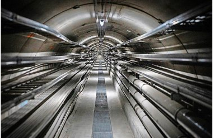
Il faut descendre dans un puits de 30 mètres pour accéder à la galerie de câbles. Rares sont les Lausannois à avoir vu ce tunnel.
