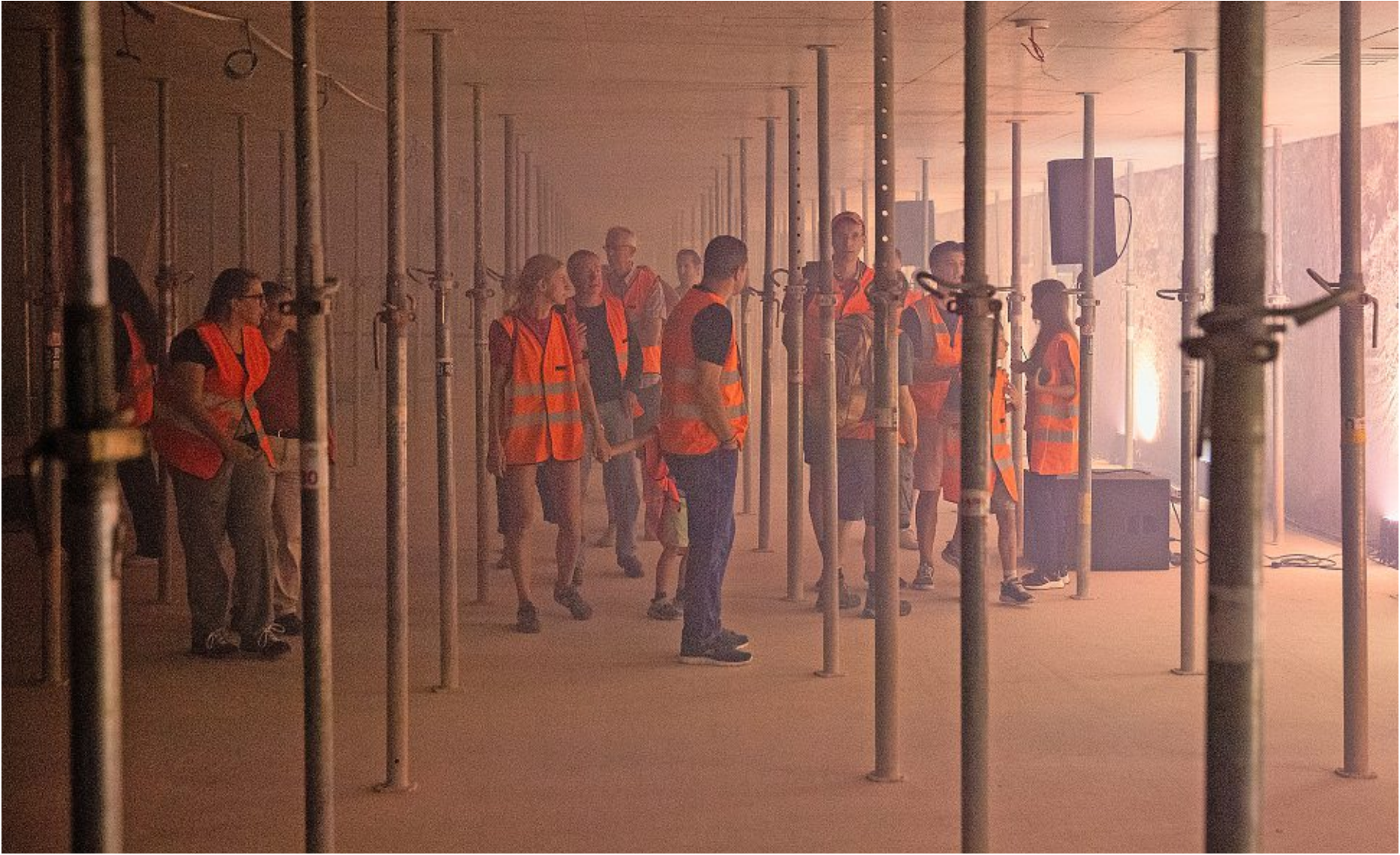
Un groupe de visiteurs se faufile parmi la forêt d'étais qui soutiennent les dalles du bâtiment Épinettes, en cours de construction.
