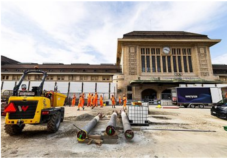
Les travaux visent à créer un espace de transit souterrain.
