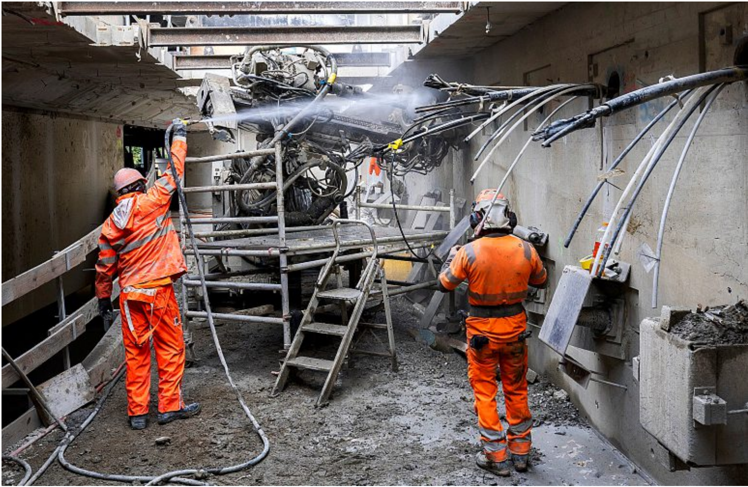
Des ouvriers s'activent sur le chantier de la gare CFF de Lausanne, avant les portes ouvertes des 5 et 6 septembre. Photos: Keystone/Cyril Zingaro
