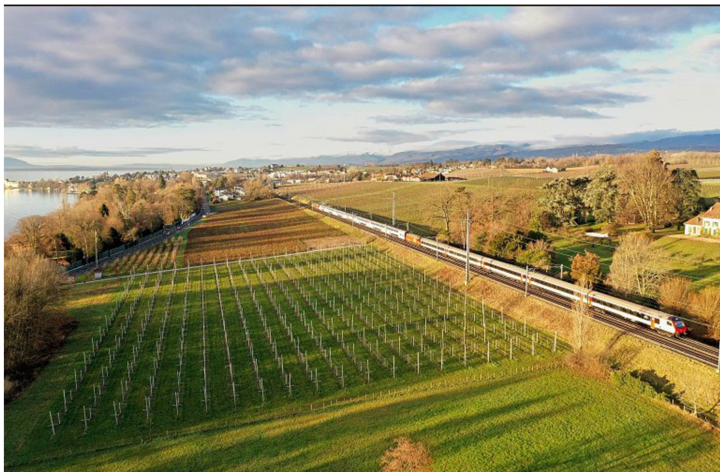
Le tunnel, ainsi que la 2e voie CFF, devrait prendre place à la sortie de Tolochenaz et «grimper» dans les vignes et les champs (à droite sur l'image) pour passer au-dessus de Saint-Prex et rejoindre Étoy en direction de Perroy. DR
