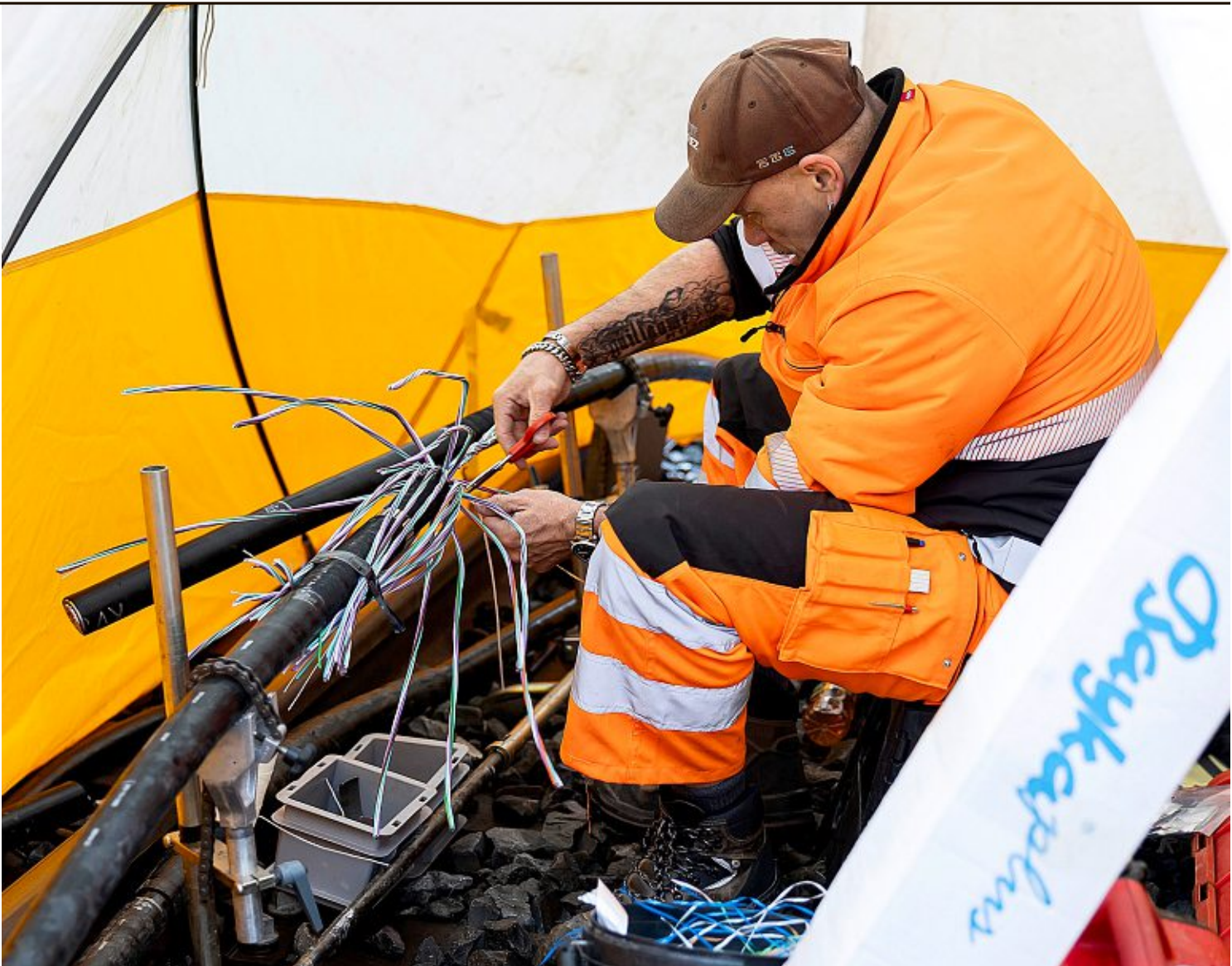
Le feu a pris à côté de la voie 1, à la gare de Lausanne. Un travail minutieux est encore en cours: 40 «câbles mères», qui contenaient chacun plusieurs dizaines de petits câbles, ont brûlé. Photos: Keystone/Cyril Zingaro
