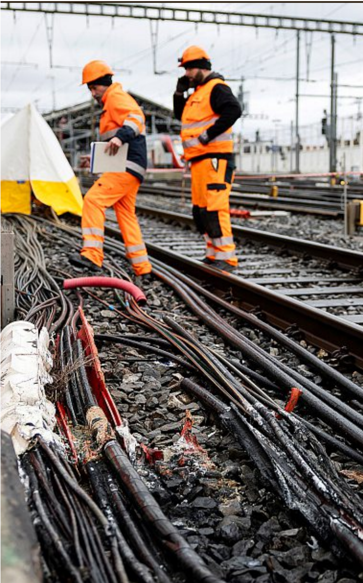
Le feu a pris à côté de la voie 1, à la gare de Lausanne. Un travail minutieux est encore en cours: 40 «câbles mères», qui contenaient chacun plusieurs dizaines de petits câbles, ont brûlé. Photos: Keystone/Cyril Zingaro
