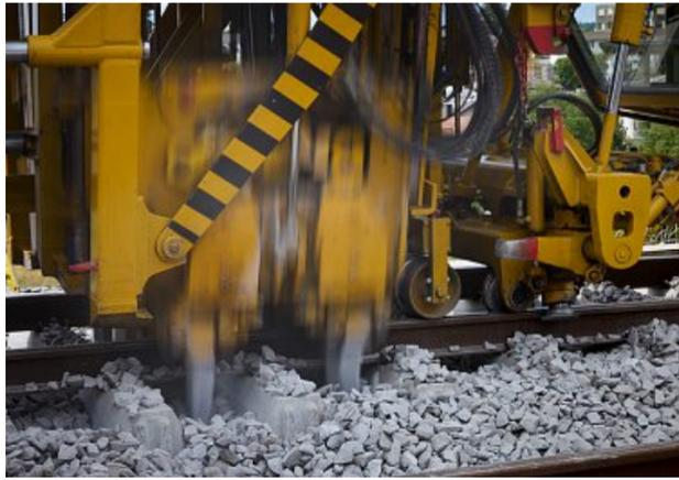
Les bourroirs secouent le ballast pour l'aplanir et le compacter.
