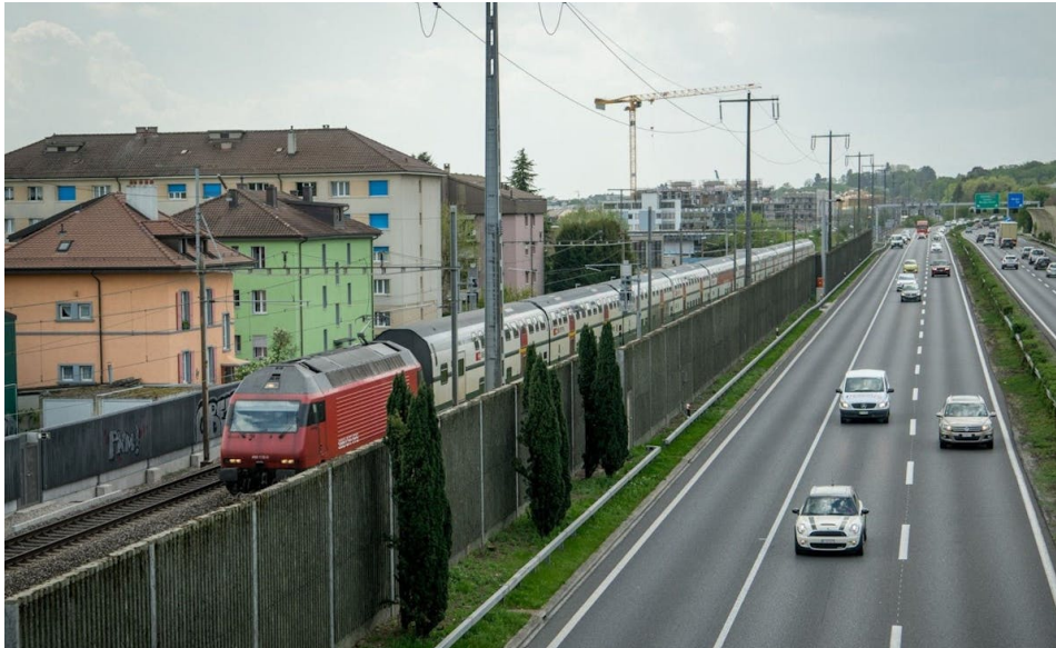
Le tunnel doit soulager la ligne du train Lausanne-Genève
