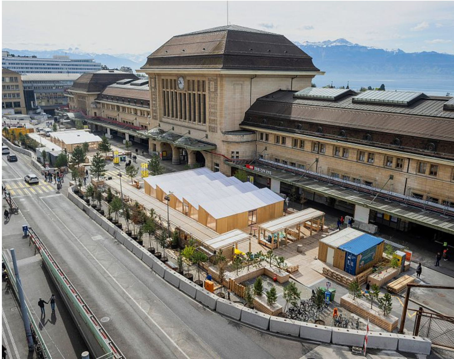
La gare de Lausanne attend toujours le début du chantier de sa mise à niveau. FLORIAN CELLA
