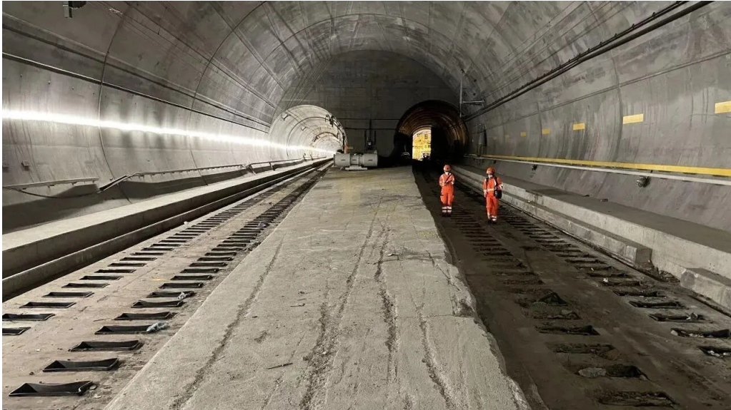
Le déblaiement effectué, il faut désormais reconstruire les infrastructures ferroviaires
