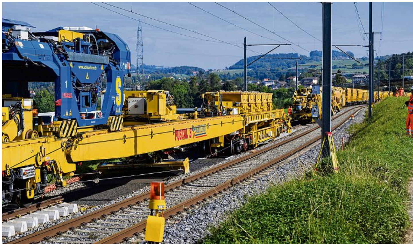
Entre Puidoux et Palézieux, une centaine d'ouvriers renouvellent actuellement 7 km de voies grâce à une véritable usine sur rail, un train de 900 m de long qui avance à la vitesse de 288 mètres par jour. KEYSTONE
