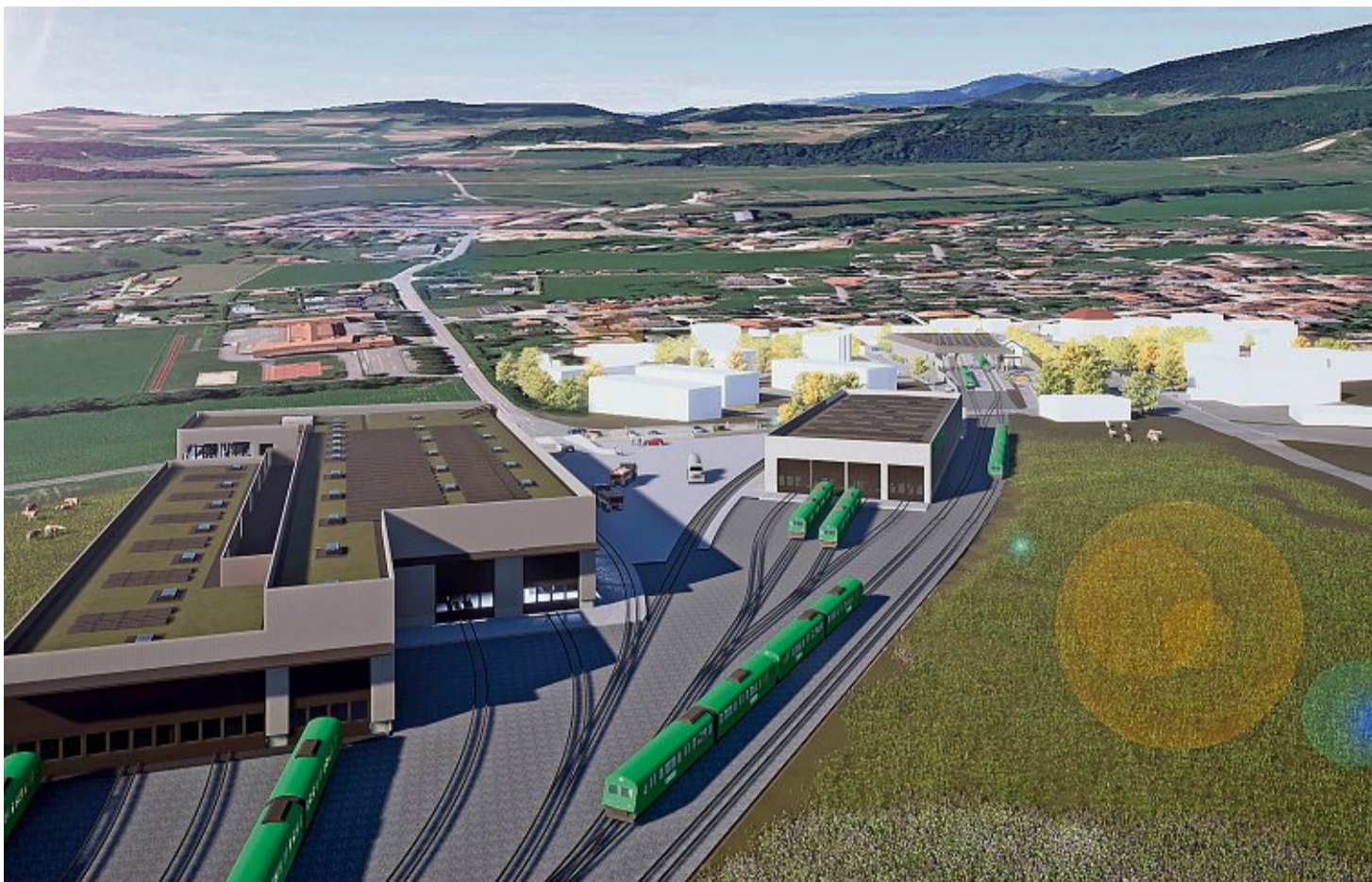
La vieille gare de Bière, à l'arrière-plan sur l'image, va être modernisée à l'horizon 2031, tout comme l'ensemble du site de maintenance et de stockage des trains de la ligne Morges-Apples-Bière. IMAGE DE SYNTHÈSE/MBC
