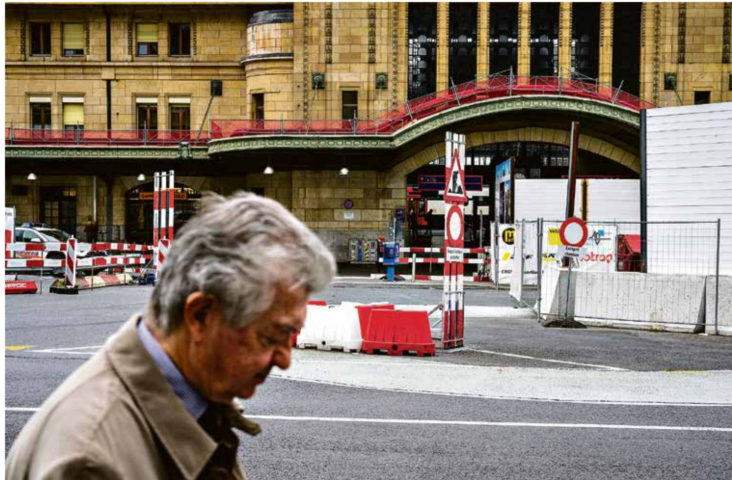
Au total, le chantier de la gare de Lausanne cumule actuellement douze ans de retard. (LAUSANNE, 12 OCTOBRE 2022/EDDY MOTTAZ/LE TEMPS)
