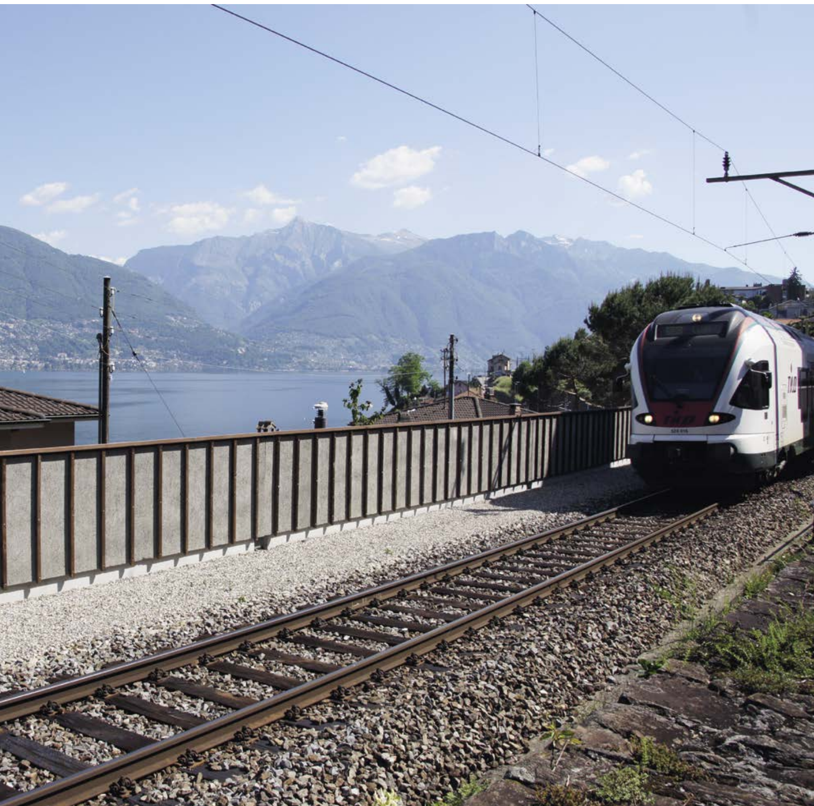
Réduction du bruit ferroviaire : parois anti-bruit à Gerra
