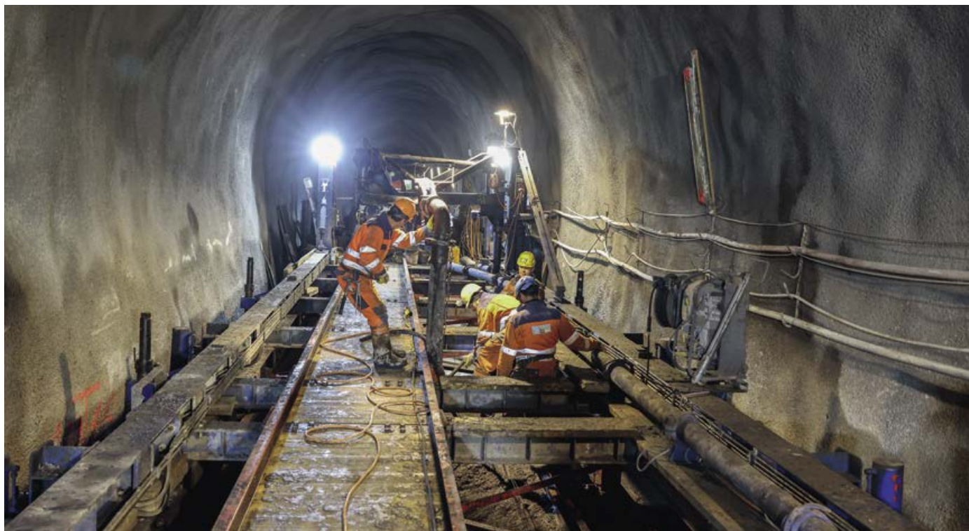
Tunnel de l'Albula II
