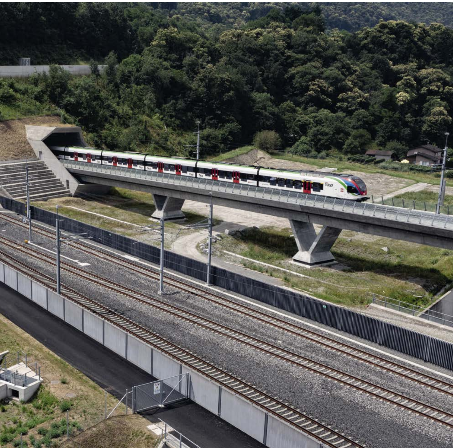
NLFA: Tunnel de base de Ceneri, portail nord Vigana
