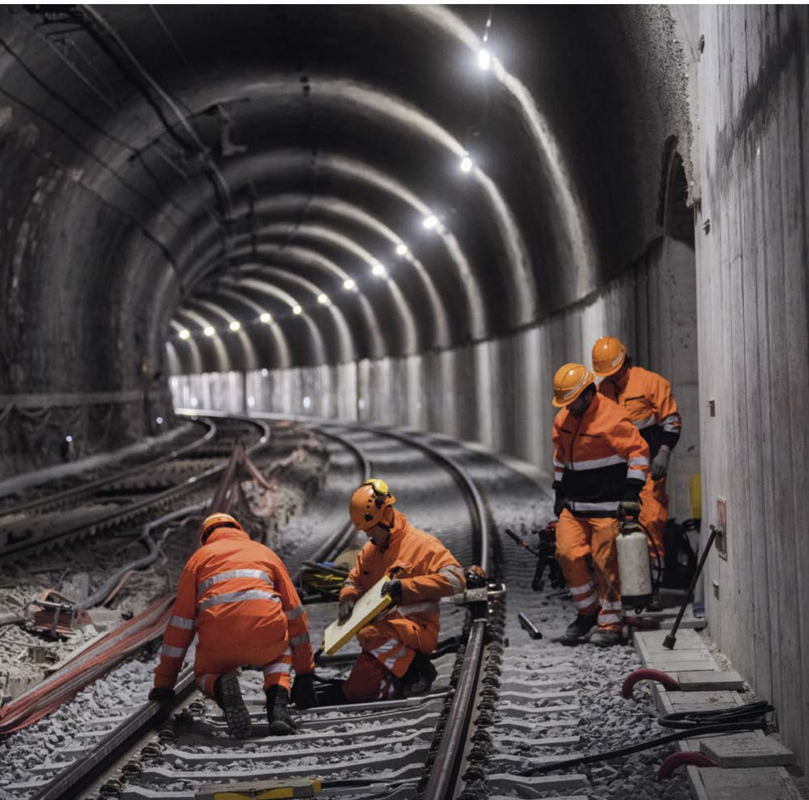
Corridor 4 mètres : ouvriers au tunnel de Paradiso
