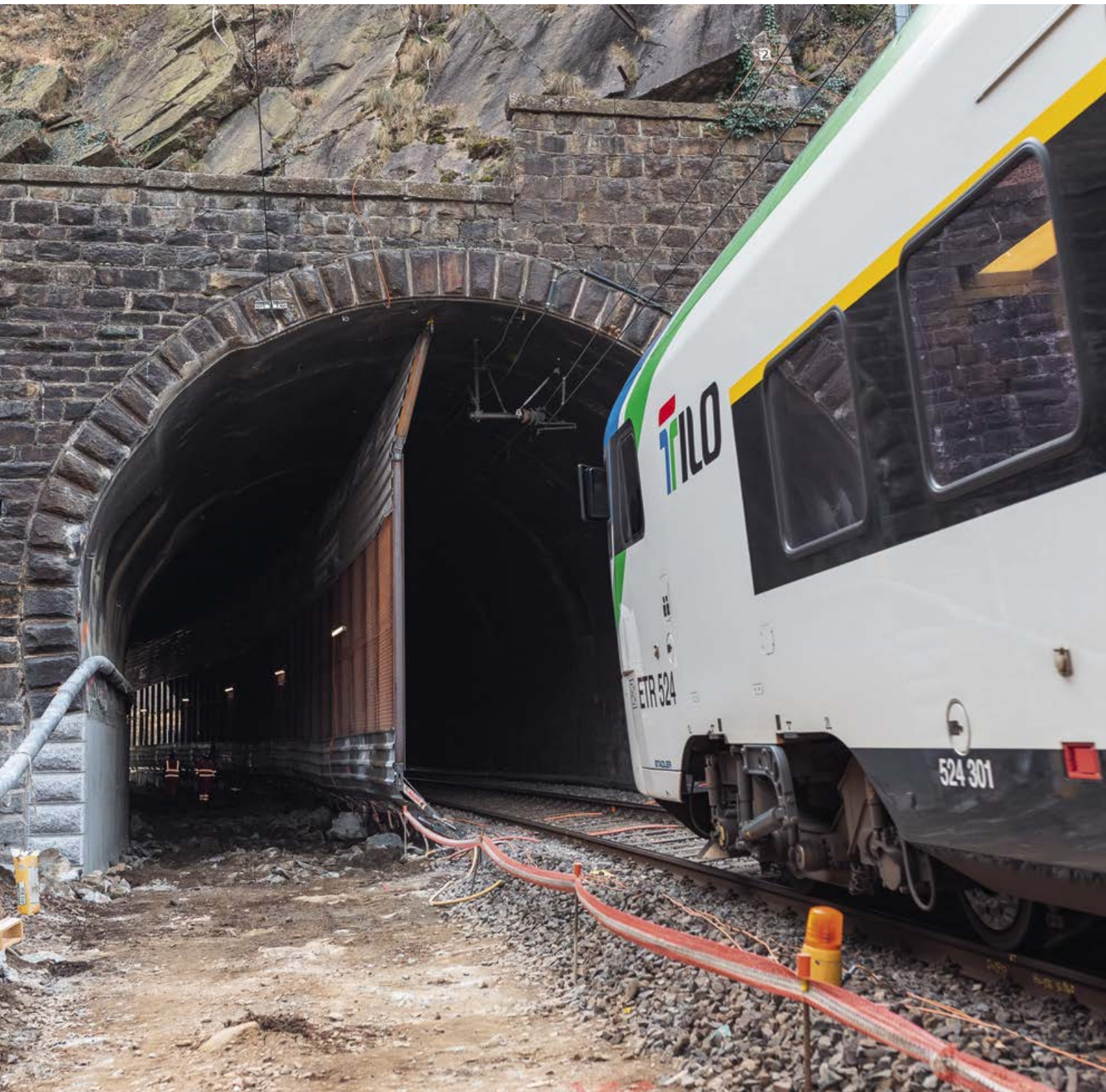
Corridor 4 mètres : ligne de faite du Ceneri, tunnel de Molincero
