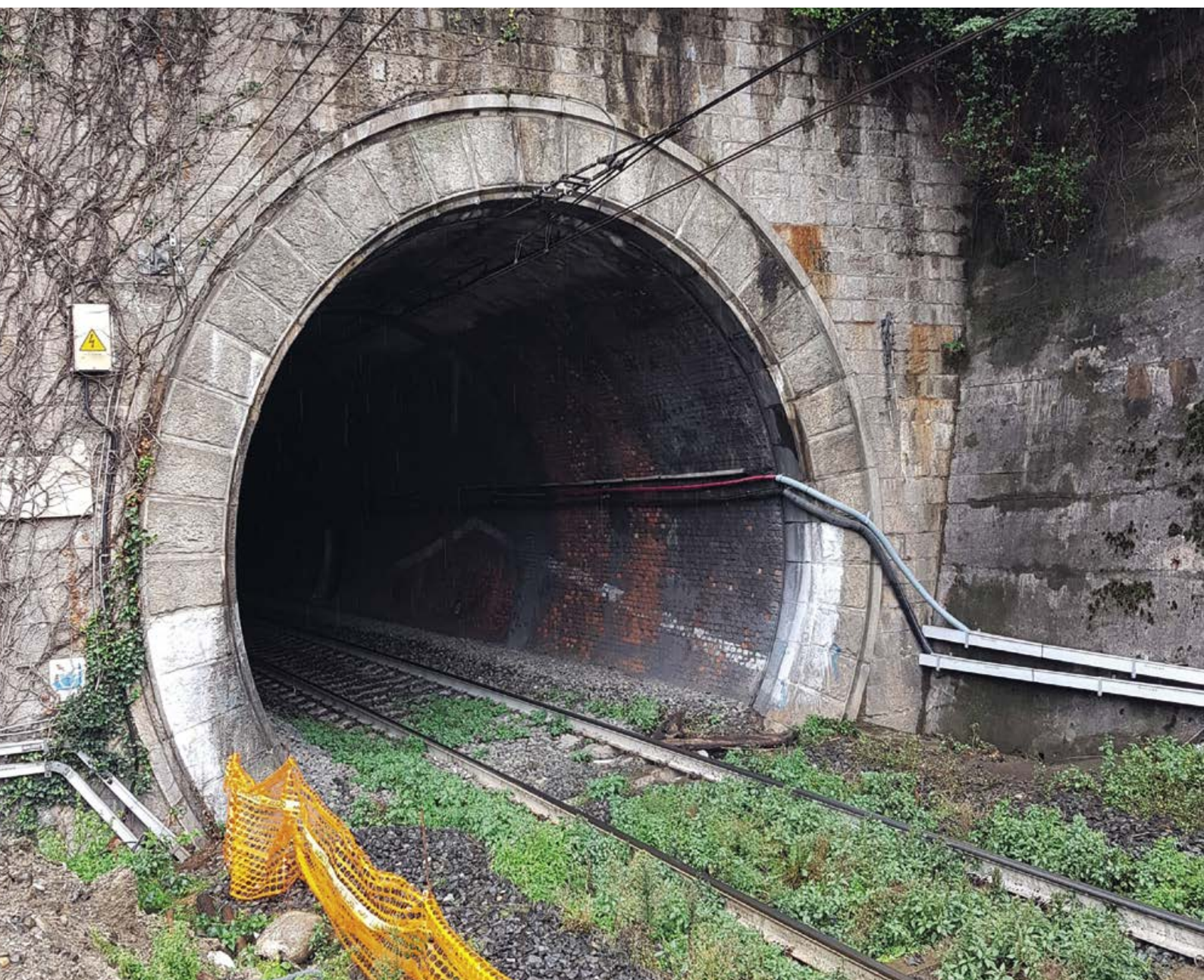
accès sud à la NLFA, revitalisation du tunnel Vergiate
