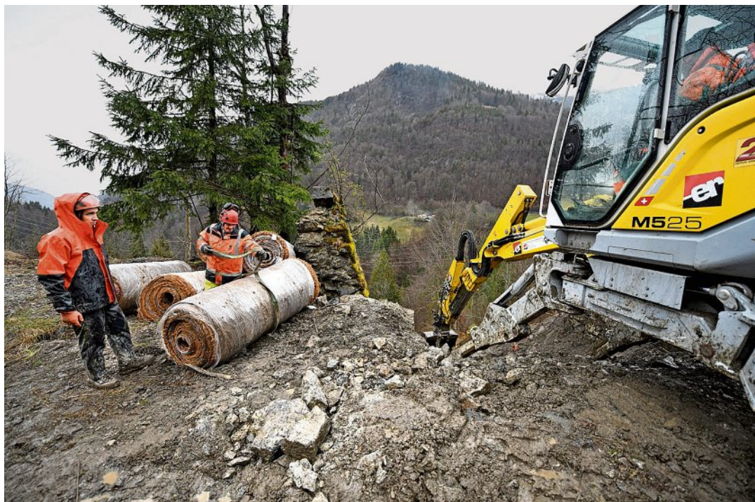
Les travaux sont compliqués, dans une zone escarpée et difficile d'accès. CHANTAL DERVEY
