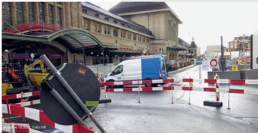
Déjà commencée : la rénovation totale de la gare de Lausanne.
