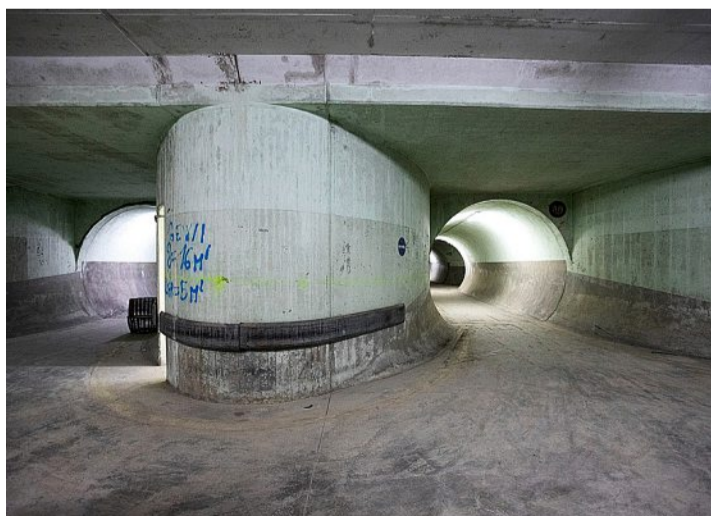
Les deux anciens tunnels postaux sous la gare relient le bâtiment de la Rasude aux quais. Ils vont être détruits.
