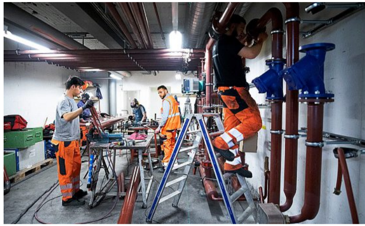
Sous la gare, les ouvriers s'activent à dévier l'enchevêtrement des réseaux de câbles.
