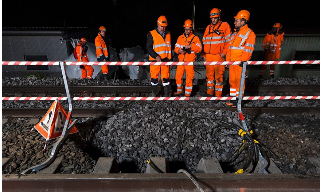
Des ingénieurs regardent le ballast déposé dans le trou sur la ligne CFF entre Lausanne et Genève à la suite d'un affaissement survenu à Tolochenaz. KEYSTONE
