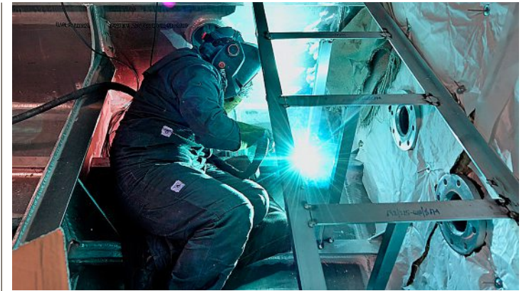
Les soudures importent beaucoup dans ce chantier, la seule superstructure étant composée de 30'000 éléments.
