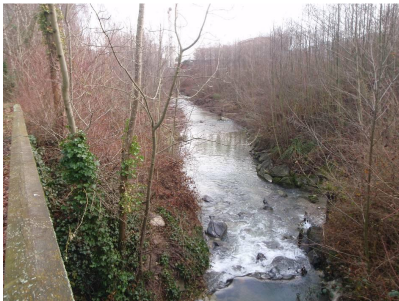
Figure 40 : La Sorge vue vers l'aval
