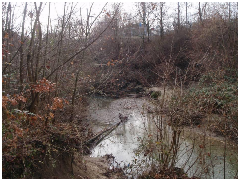
Figure 41 : La Sorge au nord de la halte du M1 - morphologie à reproduire après les travaux
