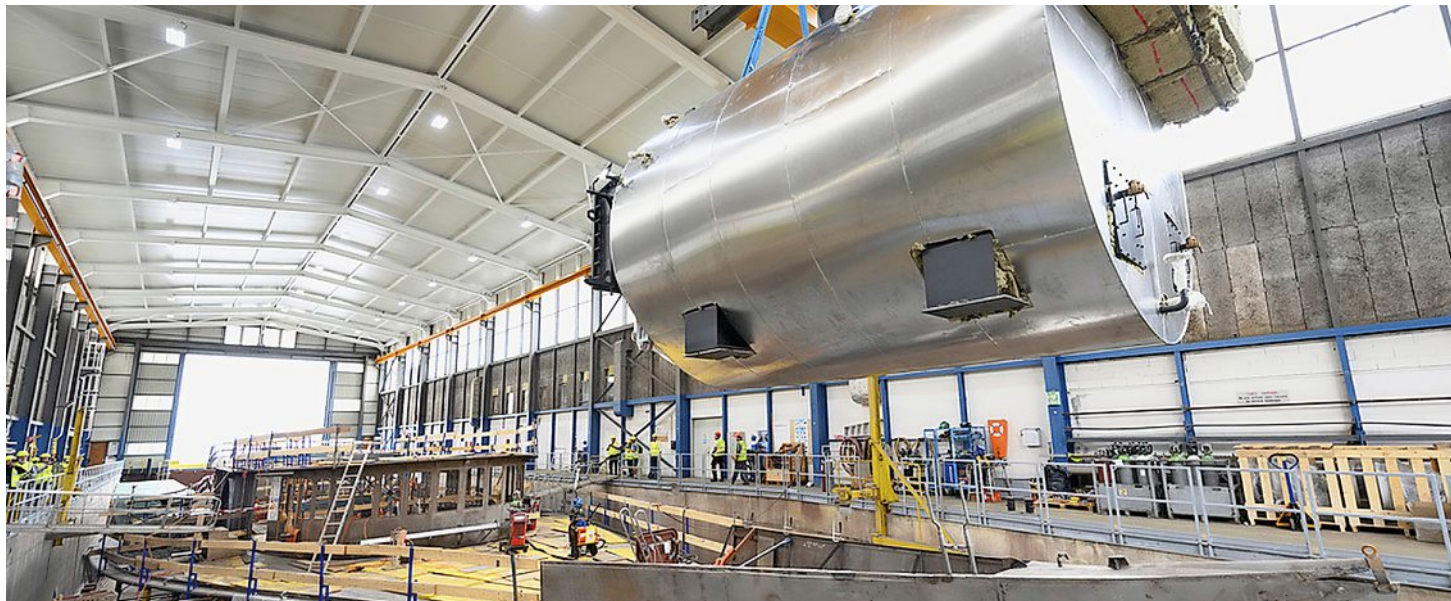
La nouvelle chaudière de 32 tonnes vole vers le cœur du navire «Rhône», en restauration depuis avril 2019.
