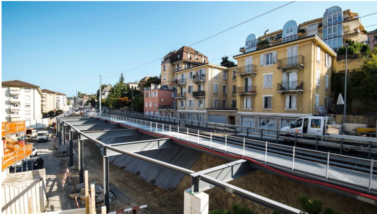
Le train vert et blanc empruntera ce pont durant deux ans, pratiquement jusqu'à la fin du chantier de percement du tunnel. PATRICK MARTIN
