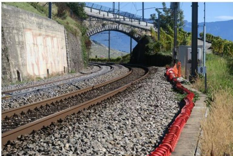
Le projet nécessite de corriger la géométrie des voies en courbe et de déplacer le mur de soutènement nord d'environ 7 m vers l'amont.
