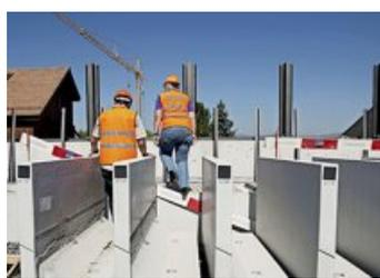
Les éléments préfabriqués en béton attendent d'être mis en place pour achever le second quai.
