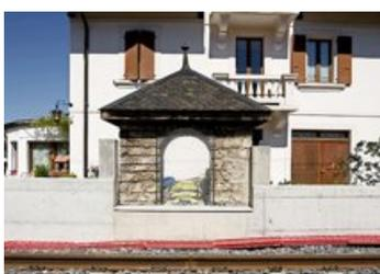
Un décrochement a été réalisé dans un mur pour éviter la démolition d'un couvert cher à un riverain.
