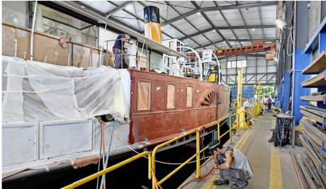
Dans le bassin de radoub de la CGN à Ouchy, la restauration complète de l'Italie se termine. Il ne reste que les finitions, peinture ou autres aménagements, à effectuer.
