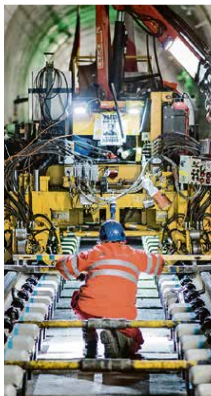
La pose des rails est un travail millimétrique. (KEYSTONE)
