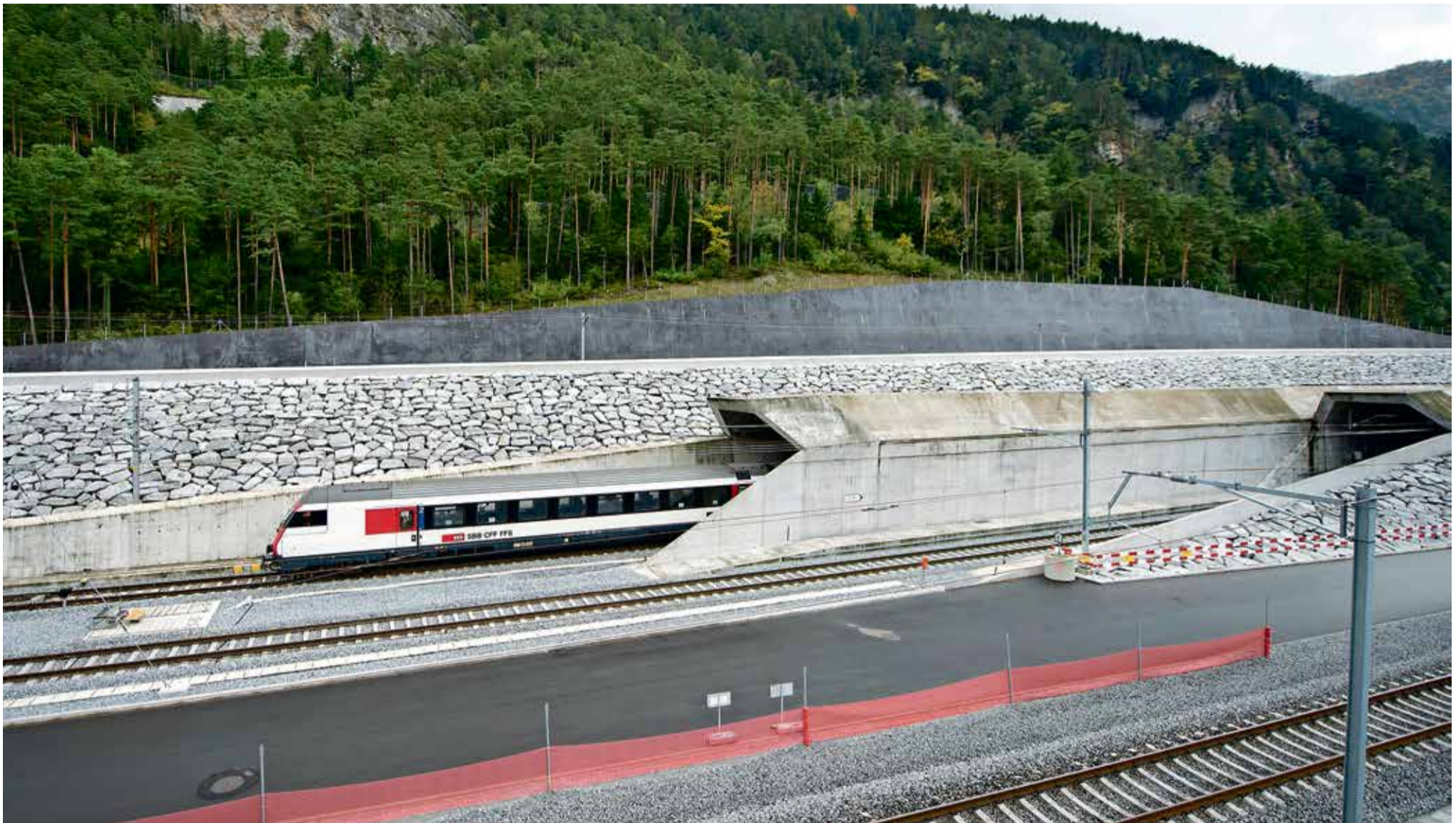
Pour éviter les effets d'aspiration provoqués par la grande vitesse, les portails des deux tubes – ici celui d'Erstfeld, du côté nord – sont décalés l'un par rapport à l'autre. (URS FLUEELER/KEYSTONE)
