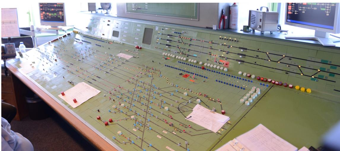
Figure 4 : Poste d'aiguillage de la gare de Lausanne de type Domino 55.
