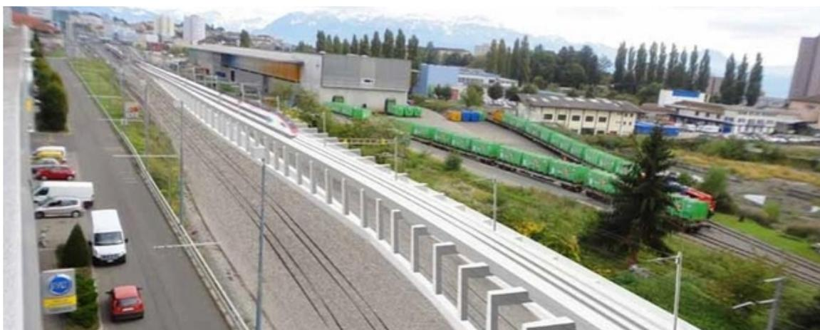
Figure 7 : Projection du futur saut-de-mouton se trouvant à la hauteur du dépôt TL à Malley. L'ICN, roulant en direction de Renens, empreinte la voie 580, soit le saut-de-mouton, qui lui permet d'enjamber les voies 380 et 480.
