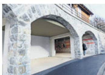
La nouvelle gare vue depuis la partie aval du village.
