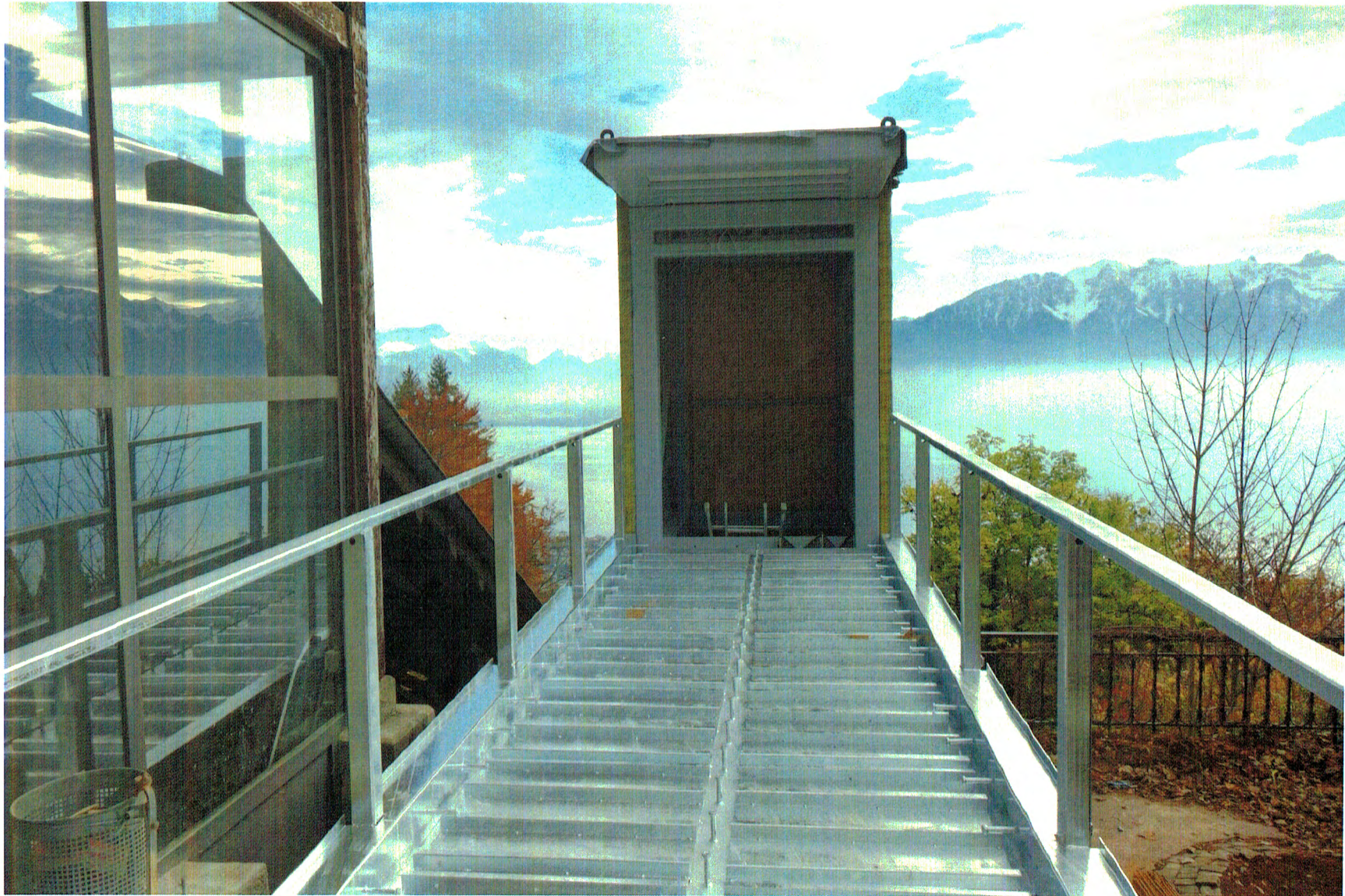
Funiculaire Vevey - Chardonne - Mont-Pèlerin - Travaux 2014
