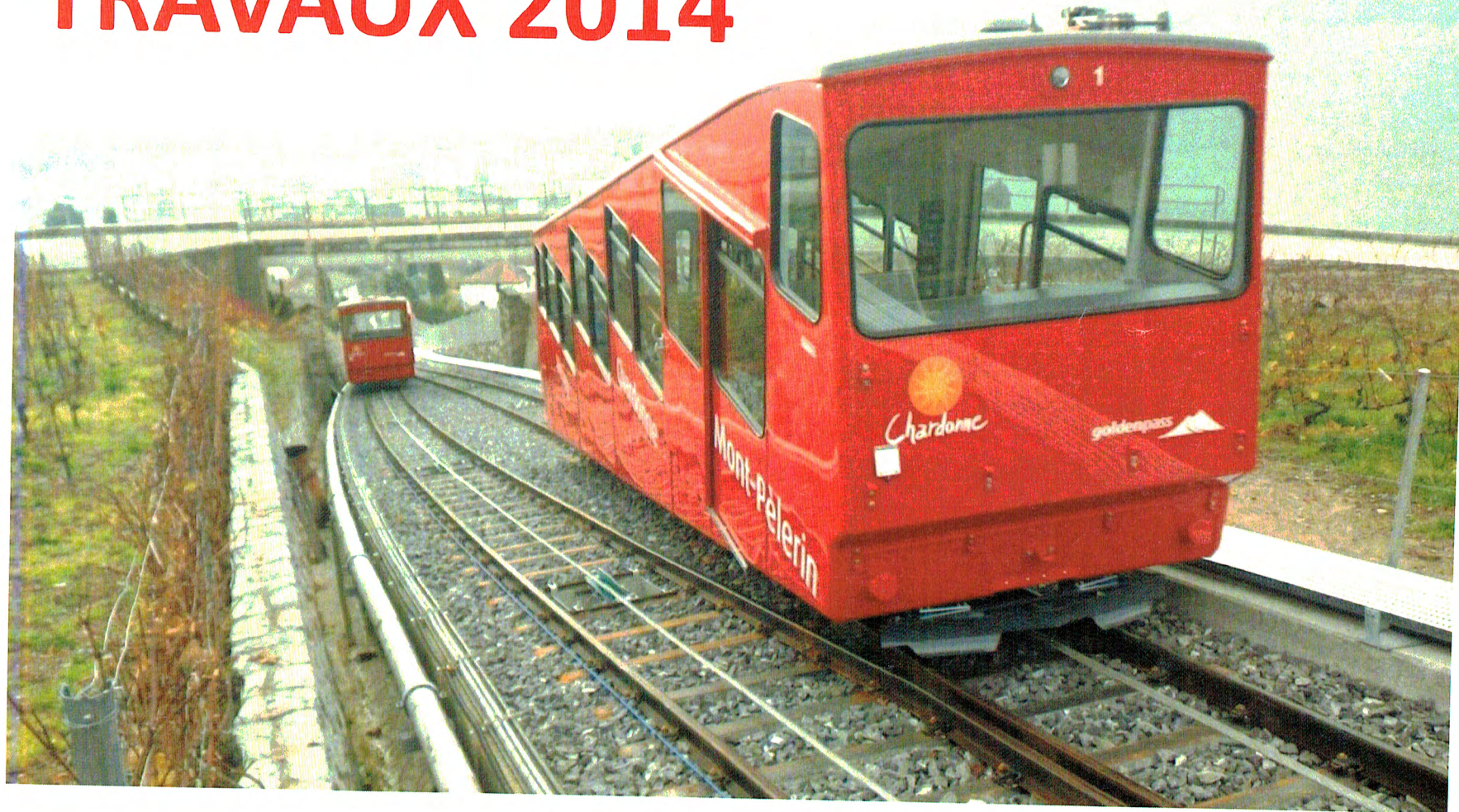
Funiculaire Vevey - Chardonne - Mont- Pèlerin - Travaux 2014
