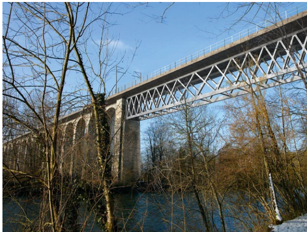
Figure 6.2. Viaduc sur la Sarine près de Gümmenen avec tablier à double voie : projet lauréat du Team Fürst Laffranchi [TEC21 2013].
