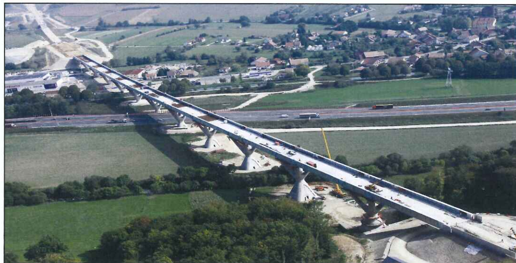
Viaduc de la Savoureuse, l'ouvrage d'art le plus spectaculaire de la ligne du TGV Rhin-Rhône(photo rff)
