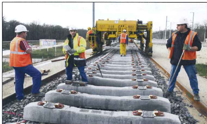
Pose de traverses à la future gare de Besançon-Auxon TGV. (rff)
