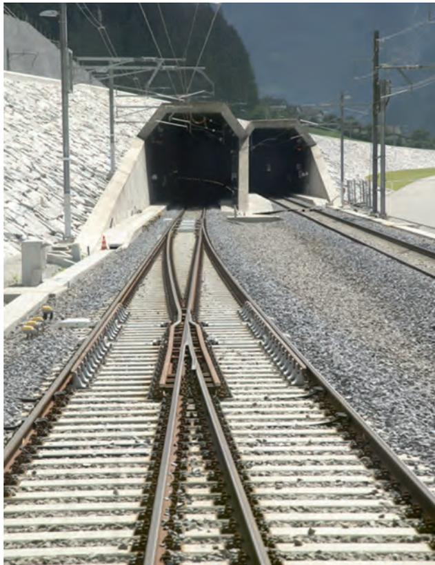
*Le ballast est essentiel à l'assurance de la qualité du roulement des trains et du confort des voyageurs (AlpTransit Gotthard SA)*
