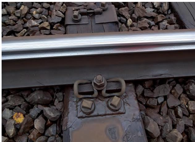
Le rail extérieur, au km 19 500 près de Leissigen (canton de Berne), dans une courbe avec un faible rayon de 280 m, présente une forte usure provoquée par le passage des trains à longue distance ; la partie supérieure du champignon du rail est devenue inexistante (P. Gerber)
