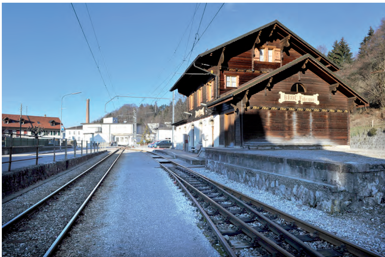
Les infrastructures ferroviaires actuelles à voie étroite de la gare de Broc-Fabrique (TPF)
