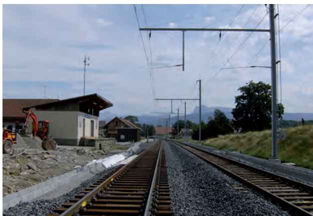
Modernisation des infrastructures ferroviaires comme ici à Vuisternens sur la ligne Bulle – Romont en 2011 (TPF)
