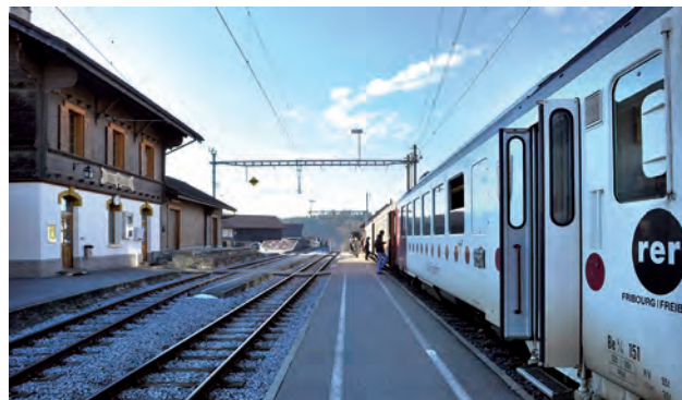
Les infrastructures ferroviaires actuelles à voie étroite de la gare de Broc-Village (TPF)
