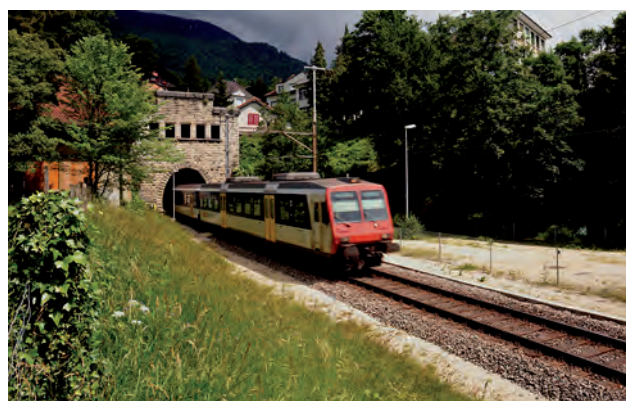
Portail Sud du tunnel Moutier - Granges
