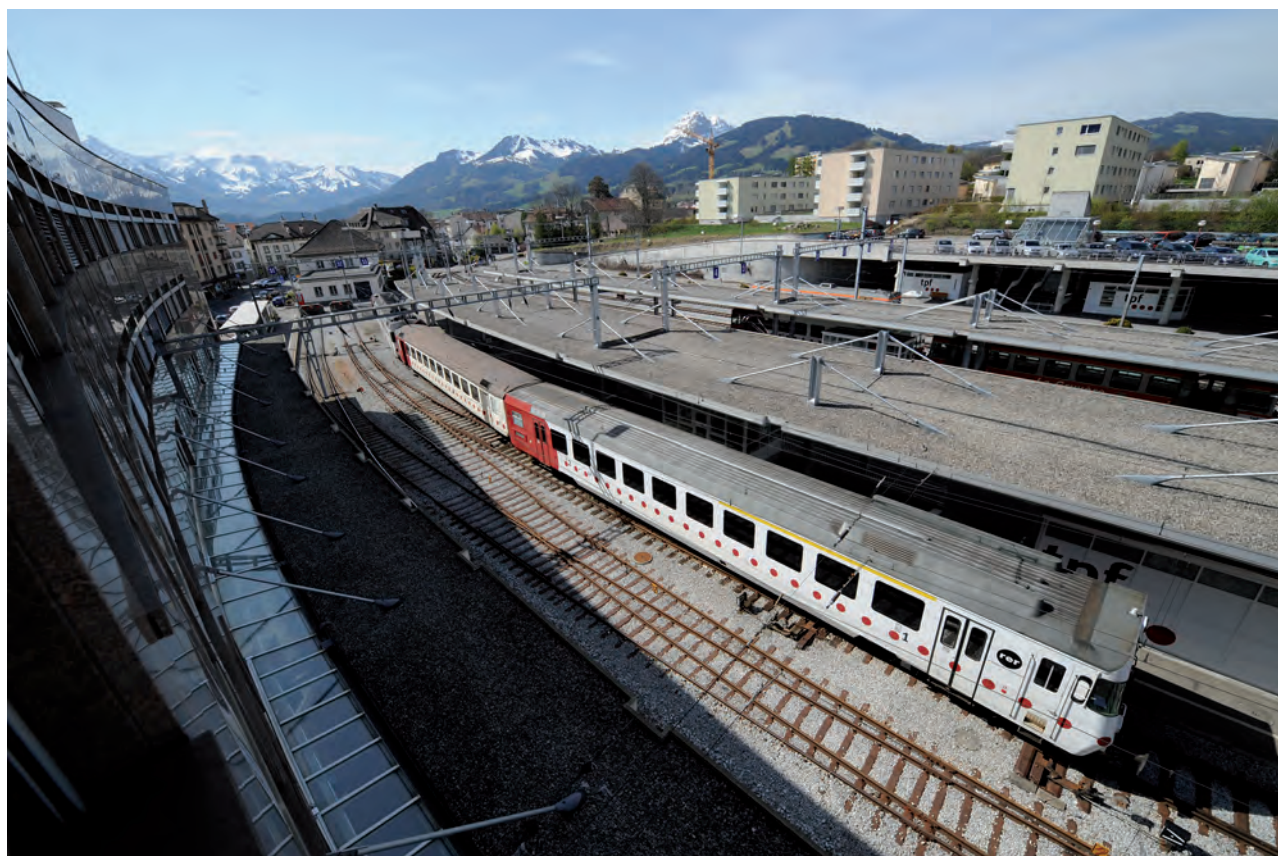
Les infrastructures ferroviaires actuelles de la gare de Bulle où cohabitent les voies normales, au premier plan, et étroites, en arrière-plan (TPF)
