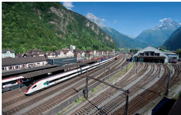
La gare d'Erstfeld au pied de la rampe nord de la ligne de mon-tagne (© Sentier Gottardo)
