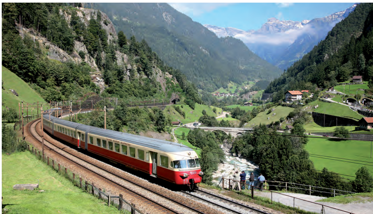
Rame automotrice quadricourant Trans Europ Express « TEE » datant de 1961 sur la rampe nord de la ligne de faîte (© CFF Historic)
