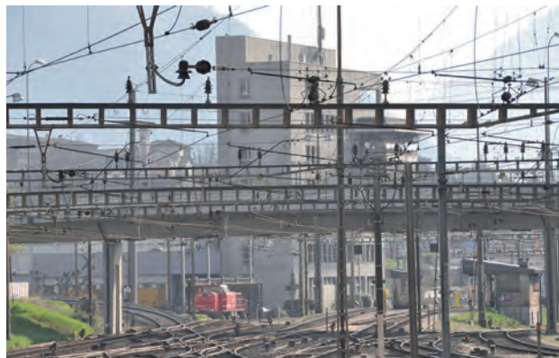
Parmi les solutions à envisager : faire de Chiasso un pôle régional de transfert route-rail en partenariat avec les entreprises locales (© SEV)
