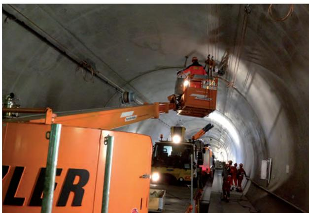
Pose des équipements de la ligne de contact (© Transtec Gotthard)
