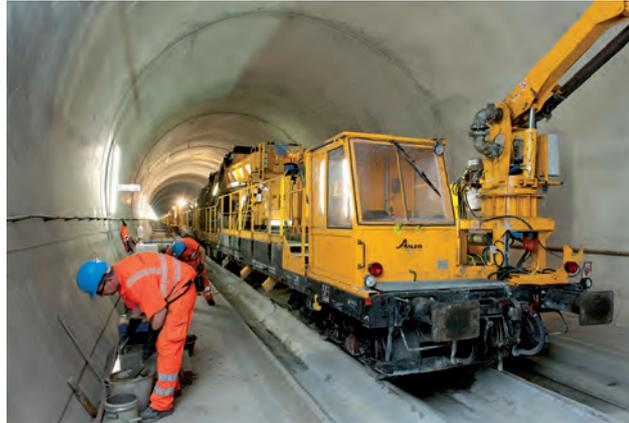
Bétonnage de la voie dans le tunnel (© CFF)
