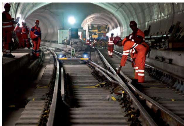
Pose d'une diagonale d'échange (aiguillage) permettant de passer d'un tube à l'autre (© AlpTransit Gotthard AG)
