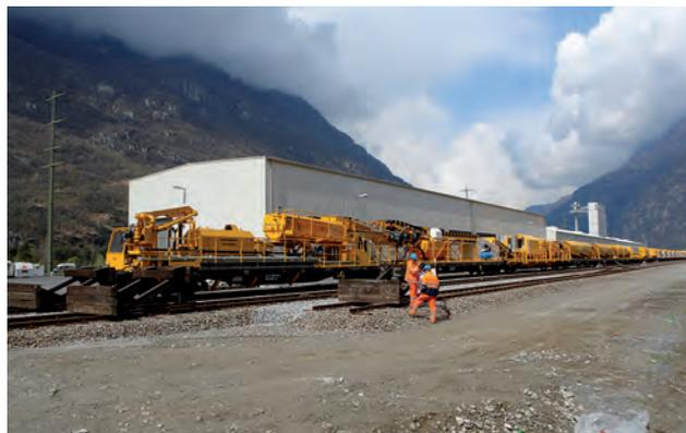
Le train pour le bétonnage de la voie (© CFF)
