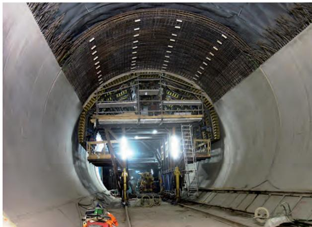
Travaux de bétonnage dans l'un des deux tubes du tunnel (© Alp-Transit Gotthard AG)
