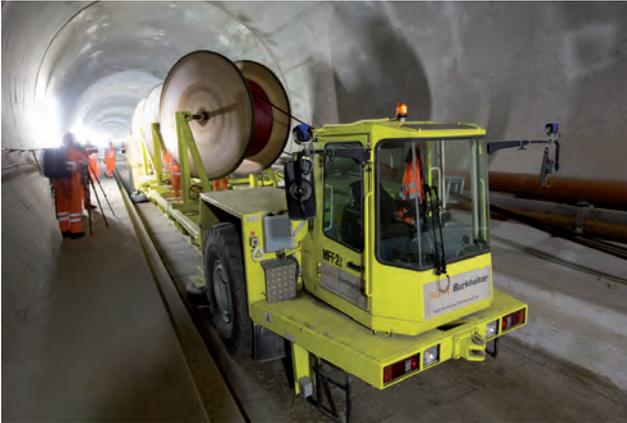
Déroutage des câbles dans le tunnel (© Transtec Gotthard)
