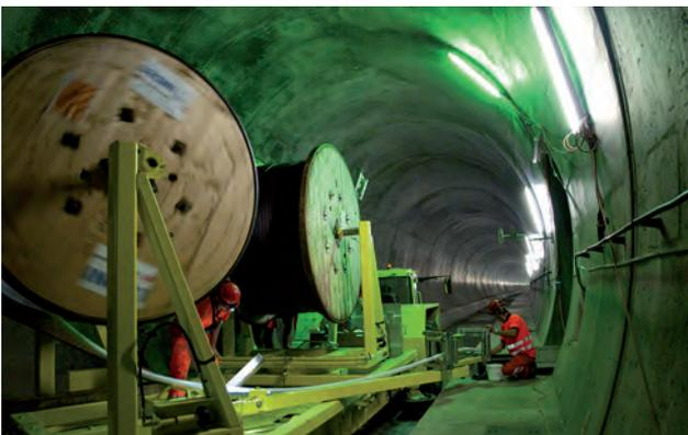
Déroutage des câbles dans le tunnel (© CFF)
