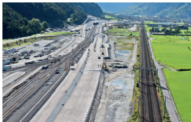
Portail nord du tunnel de base du Gothard (Alptransit Gotthard SA)
