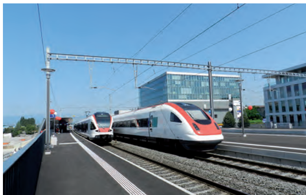
Nouvelles infrastructures et nouveau matériel roulant à Prilly-Malley (PhC)
