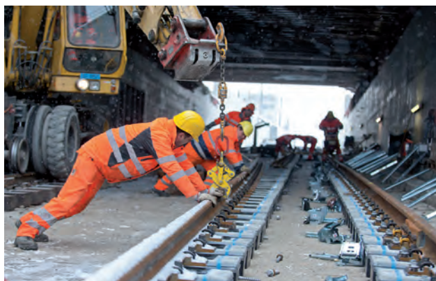
Constructeurs de voies ferrées (CFF)
