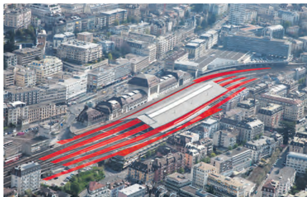
Réaménagement des quais de la gare de Lausanne (CFF)
