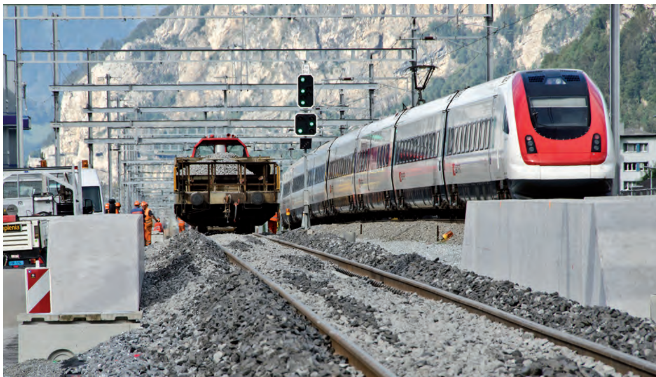
Travaux sur l'accès nord de la ligne de base du Gothard (Alptransit Gothard SA)
