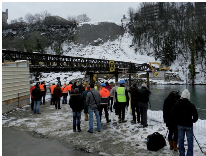
Pont provisoire jeté sur l'Arve pour les travaux du CEVA. (photo PhC)
