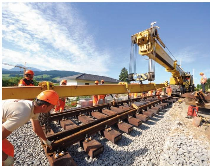
Travaux de pose d'aiguillage en gare de Vulruz. (photo sp/tpf)
