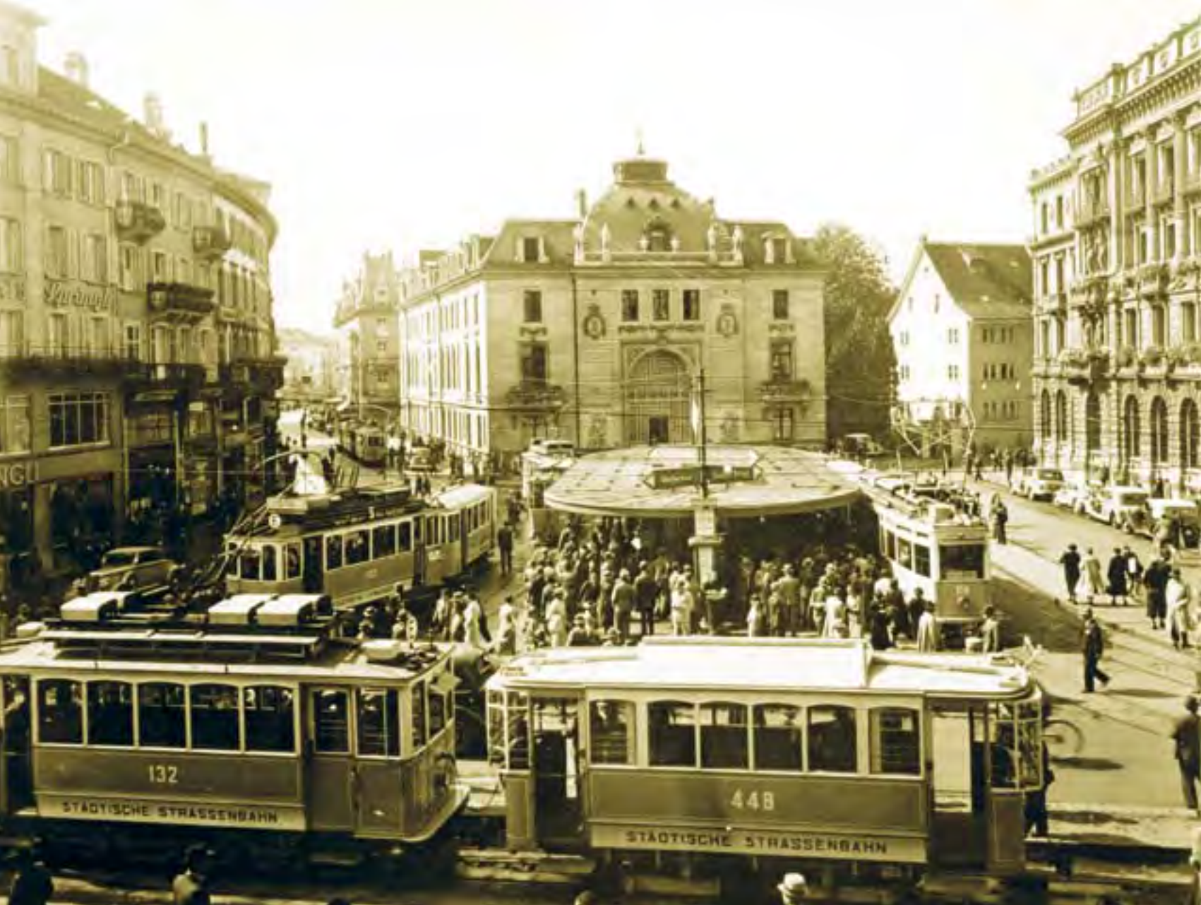
Auf dem Zürcher Paradeplatz herrschte schon 1938 ein reger Trambetrieb. Die Fahrzeuge waren unter der Bezeichnung «Städtische Strassenbahn» unterwegs.
