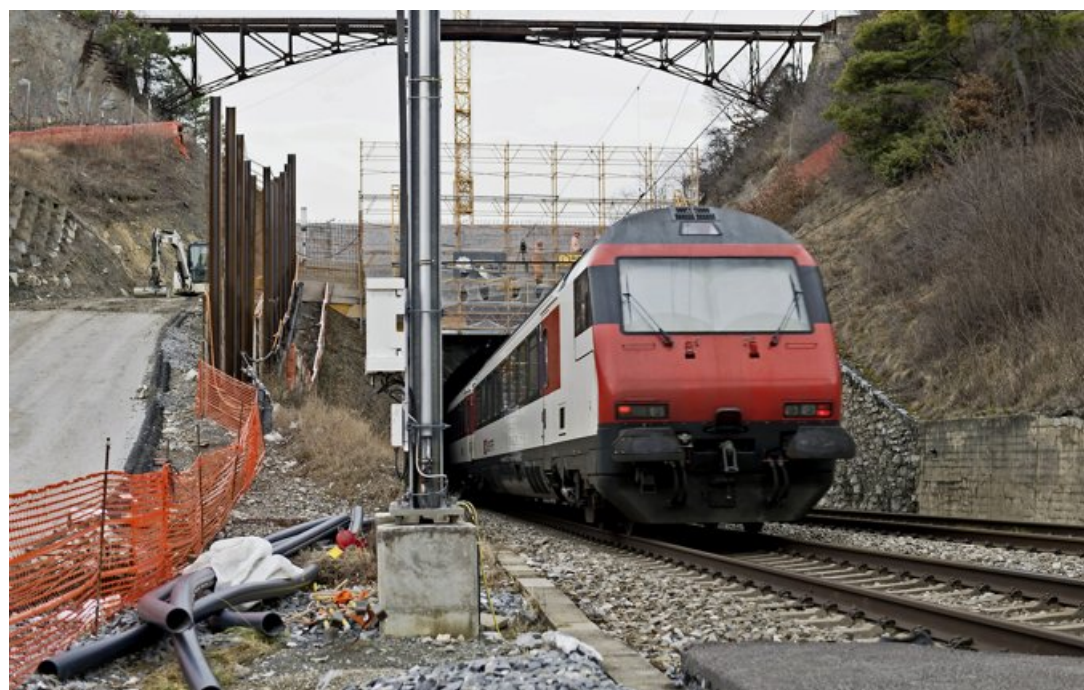
Le tunnel de la Raspille, entre Sierre et Salquenen, sera bientôt adapté au gabarit des trains à deux étages. Le chantier aura duré plus d'un an et coûté 10 millions de francs. KEYSTONE
