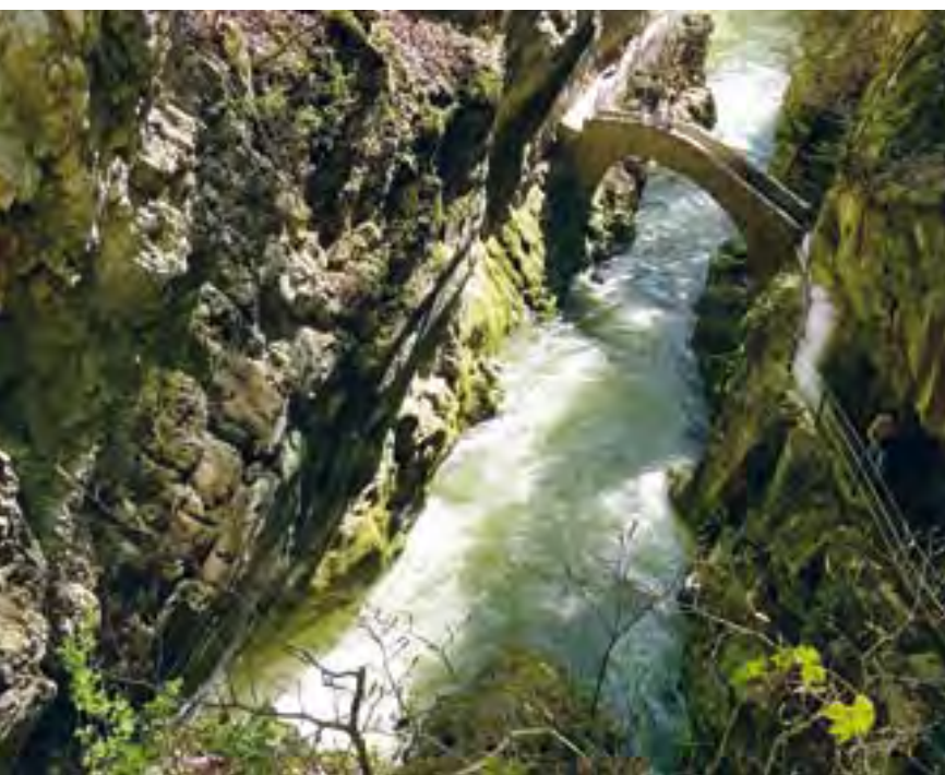
Le pont du Saut-de-Brot traverse l'Areuse à l'endroit le plus étroit de la gorge.
