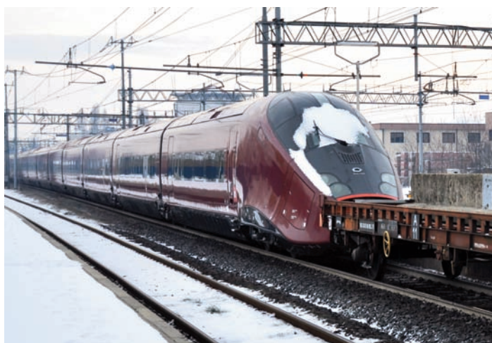
L'électrification du réseau ferroviaire joue un rôle important dans le recours aux énergies renouvelables (hydrauliques). (photo sm)
