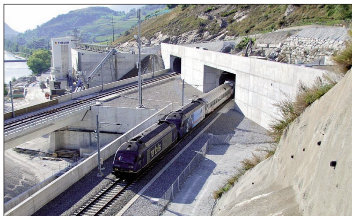
Le portail sud à deux entrées du Lötschberg, près de Rarogne. (photo sp/bls)
