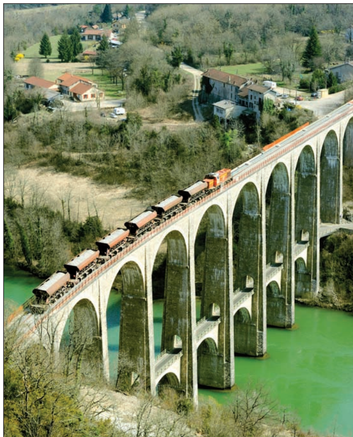
Train de travaux sur le superbe viaduc de Cize-Bolozon franchissant l'Ain.
