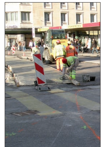
Chantier du tram à Genève. (sp)
