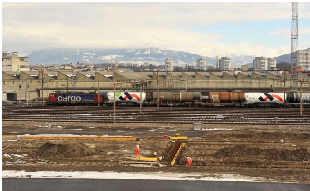
Faisceau de la gare marchandises de La Praille où les travaux battent son plein.
