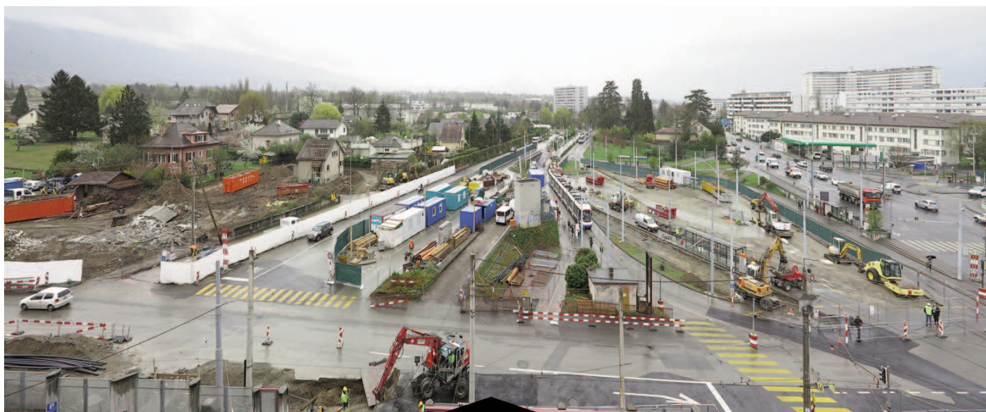
Vue panoramique du vaste chantier d'aménagement de la station de Carouge-Bachet.
