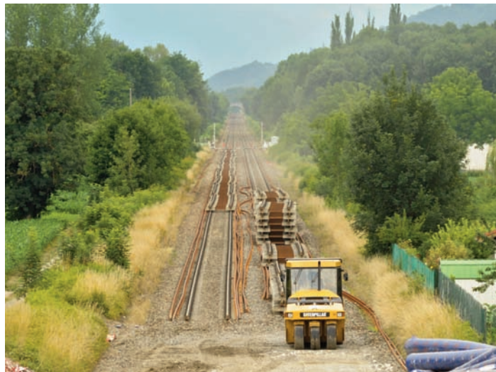
Renouvellement intégral de voie sur le Sillon alpin. (photo sp/rff)
