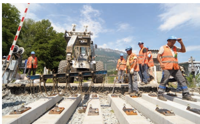
Pose de traverses à un passage à niveau du Sillon alpin. (carte sp/rff)
