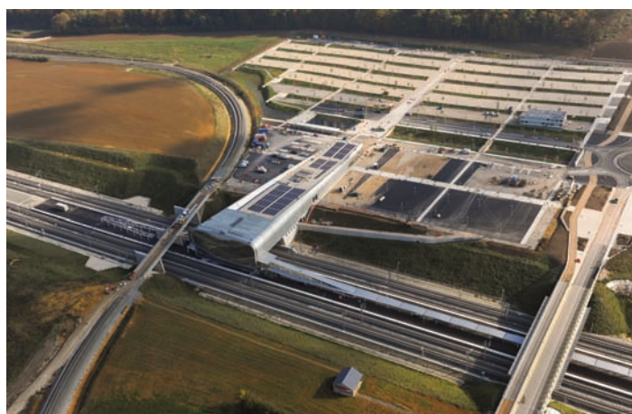
Vue de Belfort-TGV, avec à gauche le pont déjà construit de la ligne Delle-Belfort qui rouvrira en 2015. (snct/arep)
