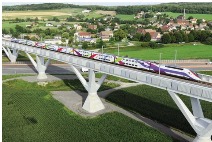
Vue aérienne du viaduc de la Savoureuse. (photo sp - rff/labservices)
