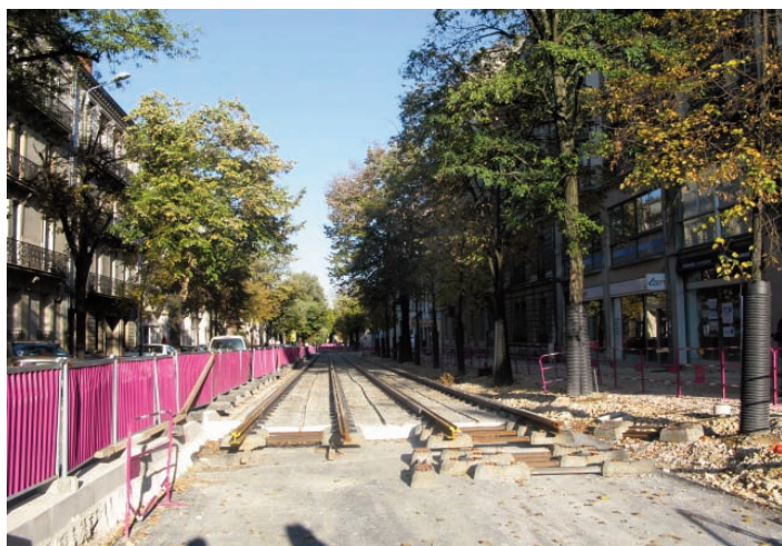
Les travaux battent son plein au centre de Dijon (photo bln)
